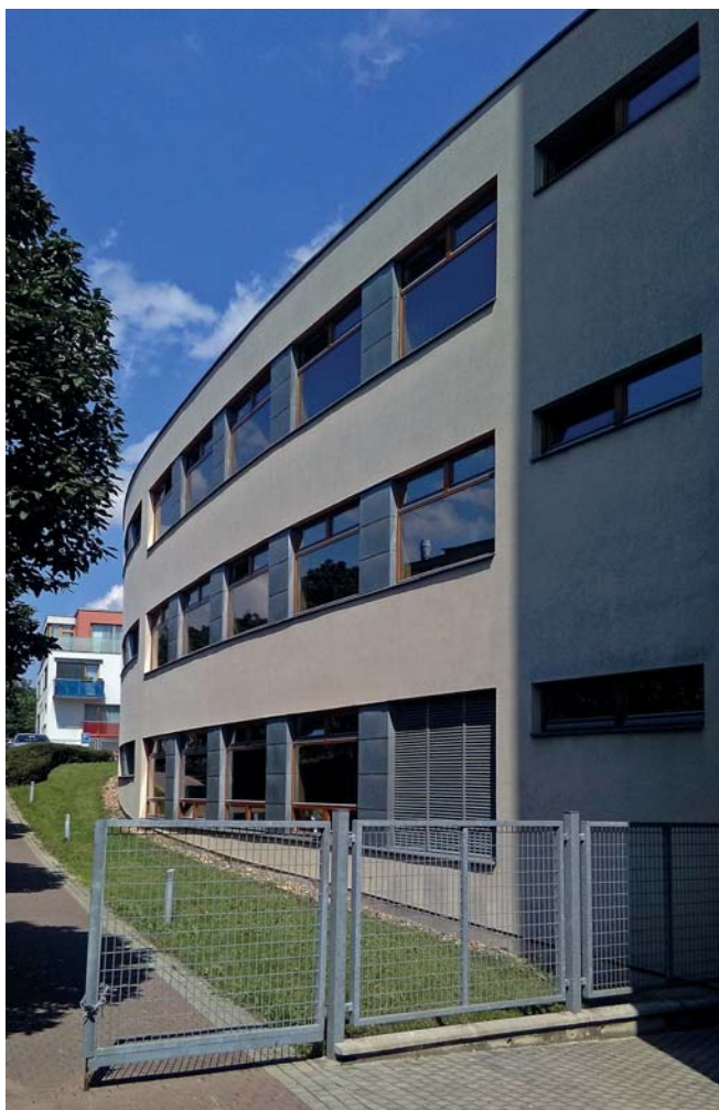
Obr. 46 Nová budova ÚAZK v Praze-Kobylisích
