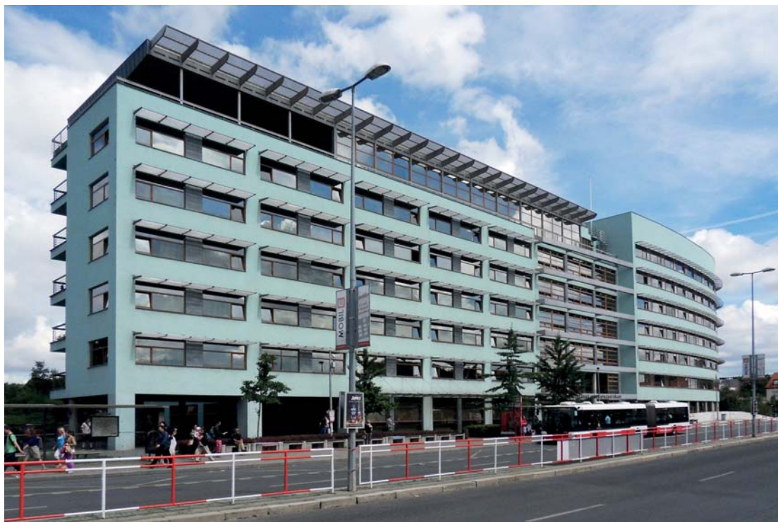
Obr. 81 Budova zeměměřických a katastrálních úřadů v Praze 8 Kobylisích
